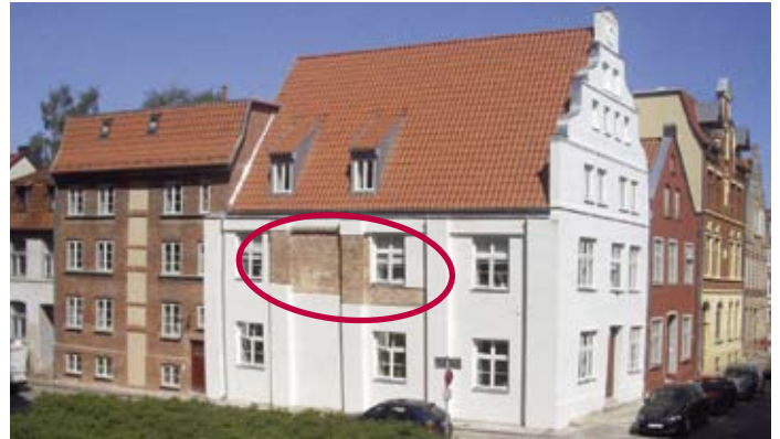
Sichtbares historisches Mauerwerk aus dem Mittelalter mit originalem Fugenstrich
