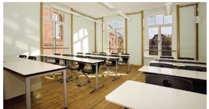
In den Musikräumen im Obergeschoss wurde nach erforderlicher Deckenbalkensanierung und -verstärkung der originale Dielenboden wieder eingebaut. An den Wänden wurde die originale Farbgebung aus der Erbauungszeit rekonstruiert.
